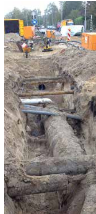
Rioolwerkzaamheden in Oss, waar de gemeente de resterende levensduur van het riool kan voorspellen met een nauwkeurigheid van ongeveer vijf jaar
